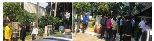
รูปที่ 2 การติดตั้งสถานีชาร์จรถยนต์ไฟฟ้า สาธารณชน
